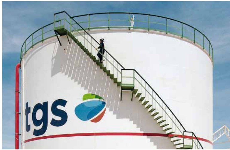
La obra. Se contempla la construcción de un poliducto de 573 kilómetros.
